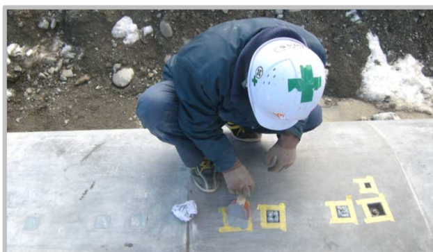
⑥ 仕上げ工(充填材充填)
