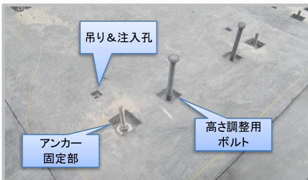
④ パネル設置工(パネル固定)
