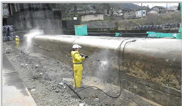
① 下地処理工(高圧洗浄)
