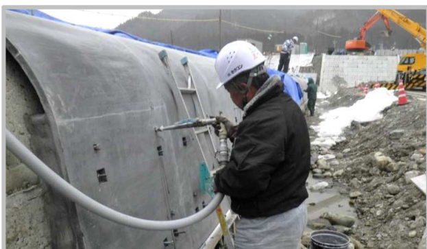
⑤ 無収縮グラウト充填工
