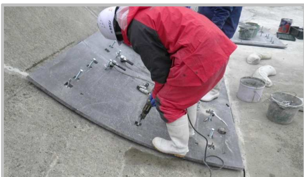
③ アンカー工
