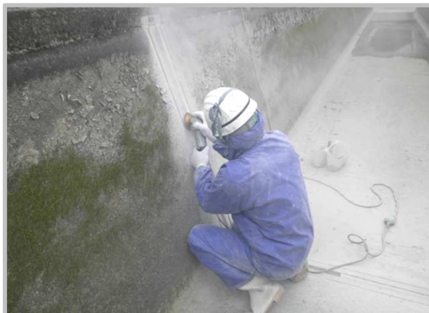
① U字溝成形工 ② 切削工
