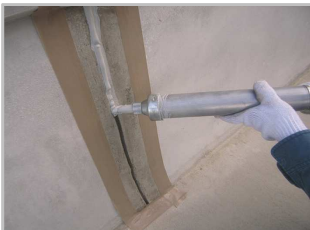
③ プライマー塗布工(1次) ④ シーリング材充填工
