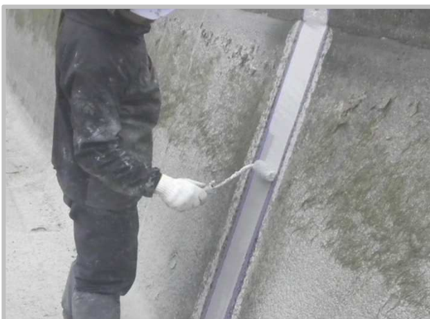
⑦ トップコート塗布工
