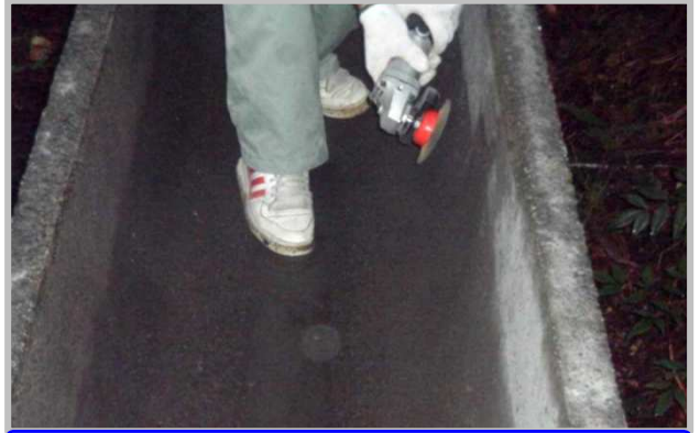
② 下地処理工(ケレン・高圧洗浄)
