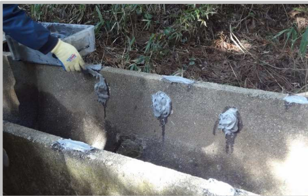
③ プライマー・接着剤塗布工
