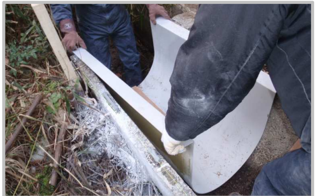
④ FRPフリュームカバー設置工
