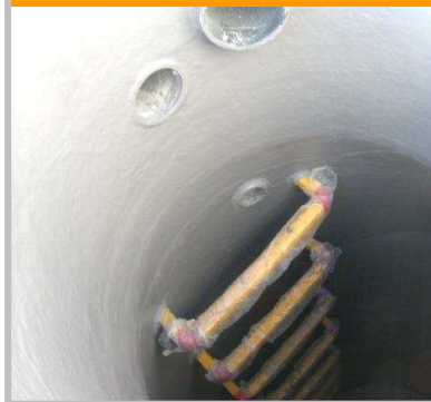
工場排水処理施設(薬液槽等) (エポマーGP-303/VE-200)
